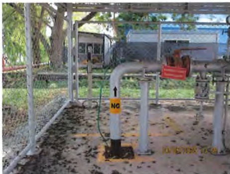
ภาพที่ 2.2-52 ข้อความแสดงทิศทางการหมุนวาล์วและข้อความแสดงทิศทางการไหลในท่อขนส่งก๊าซธรรมชาติ
