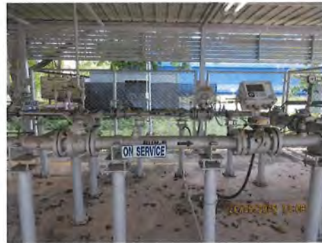
ภาพที่ 2.2-52 ข้อความแสดงทิศทางการหมุนวาล์วและข้อความแสดงทิศทางการไหลในท่อขนส่งก๊าซธรรมชาติ
